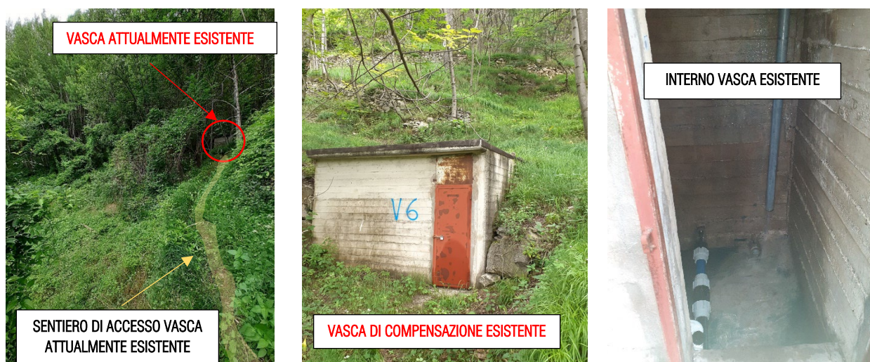
Figura 20. Dettagli dello stato di fatto dell'edificio in cls attualmente esistente adibito a vasca di compensazione.
